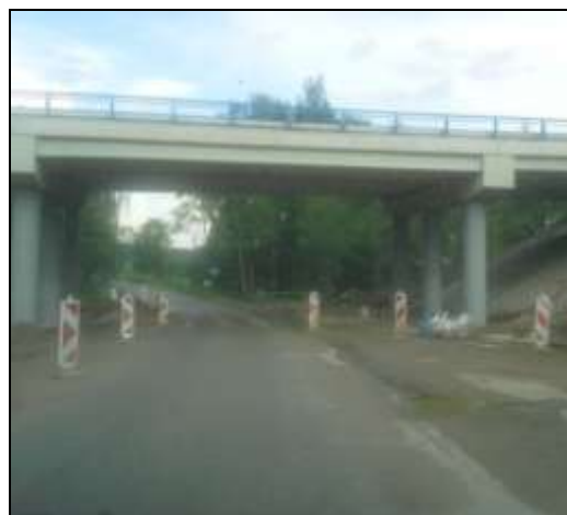
Obr. č. 8 - Mostní pilíře v blízkosti vozovky [vlastní zdroj]
