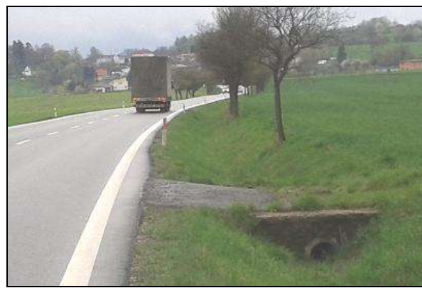
Obr. č. 11 - Betonový propustek [vlastní zdroj]
