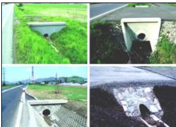
Obr. č. 10 - Betonové propustky [15]
