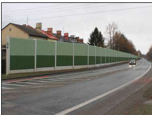
Obr. č. 17 - Protihluková stěna[12]
