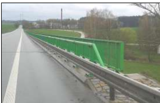
Obr. č. 5 - Mostní svodidlo a zábradlí na mostě [vlastní zdroj]
