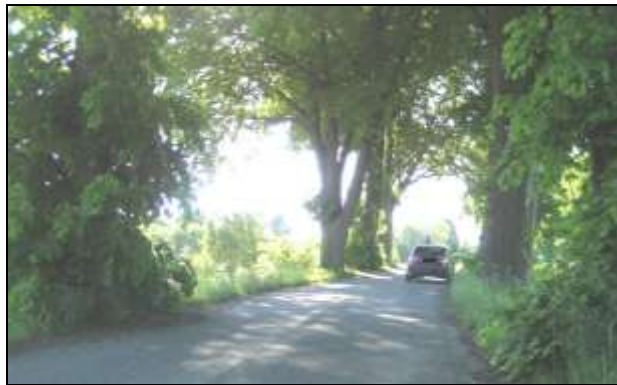
Obr. č. 4 - Neudržovaná alej lemující velmi úzkou silnici [vlastní zdroj]
