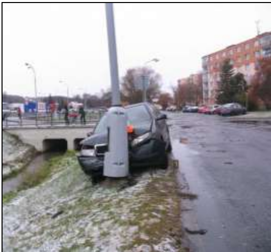
Obr. č. 15 - Sloup veřejného osvětlení po nehodě [8]
