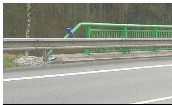
Obr. č. 6 - Zábradelní svodidlo [vlastní zdroj]
