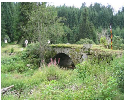
obr. 82 starý most na hraničním přechodu
