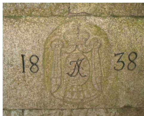
obr. 50 Nápis ve stěně dolního portálu
