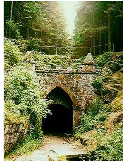
obr. 70 Horní portál tunelu
