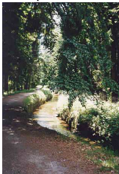
obr. 30 Plavební kanál nad Novou Pecí
