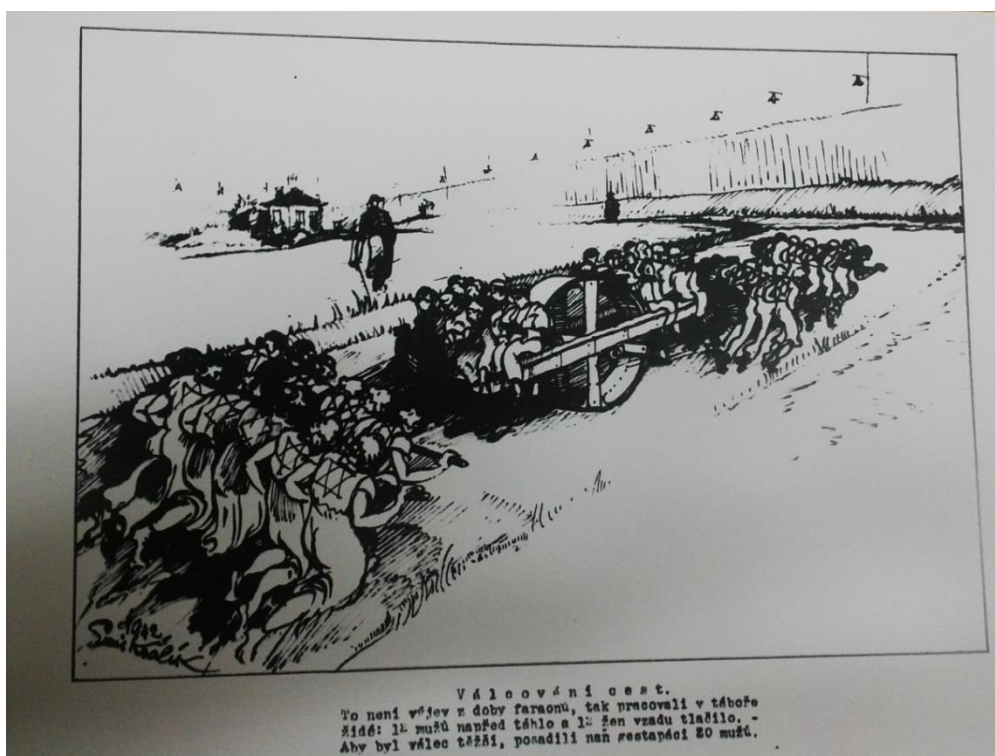
[př. č. 8] Válcování silnice
