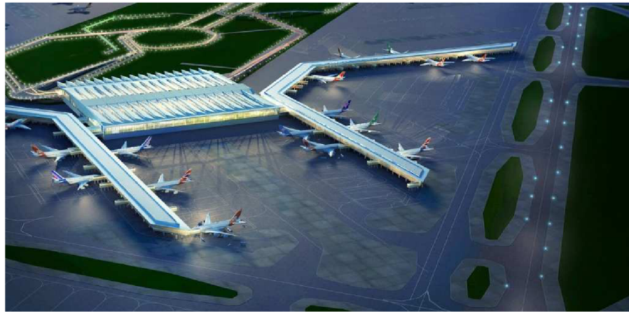
Obr. 18: Terminál 3 letiště Delhi využívající sběrnici KNX/EIB
