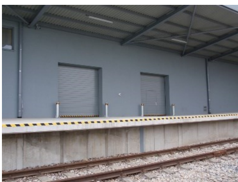
Obr. 3.11 Venkovní pohled na přístup z železniční rampy do multiskladu
