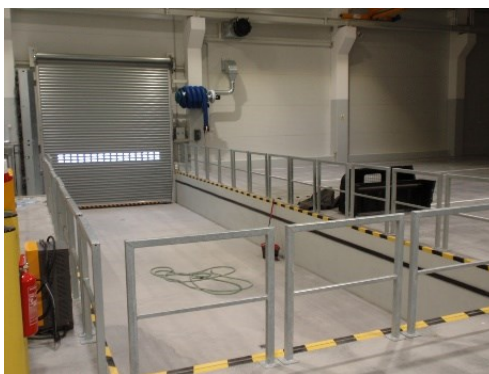
Obr. 3.15 Vnitřní pohled na sníženou rampu
