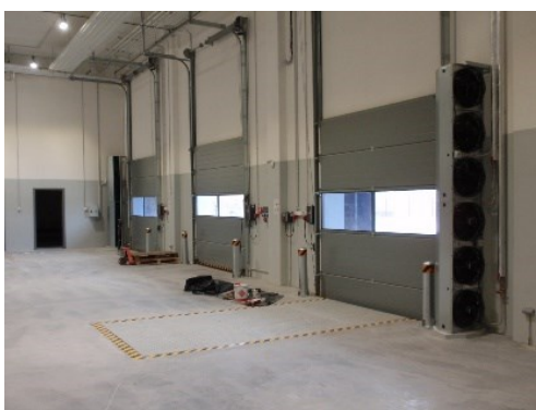
Obr. 3.12 Vnitřní pohled na přístup z multiskladu na železniční rampu
