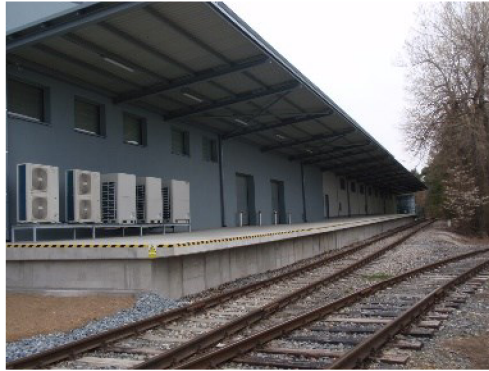
Obr. 3.10 Železniční rampa multiskladu
