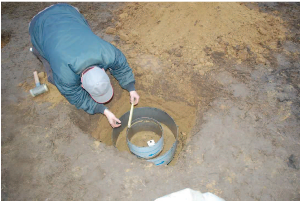
Měření hloubky zaražení válce
