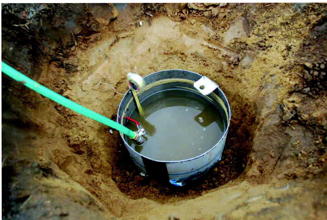
Plnění vsakovacího válce
