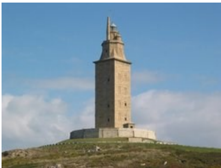
Tower of Hercules (Torre de Hercules)
