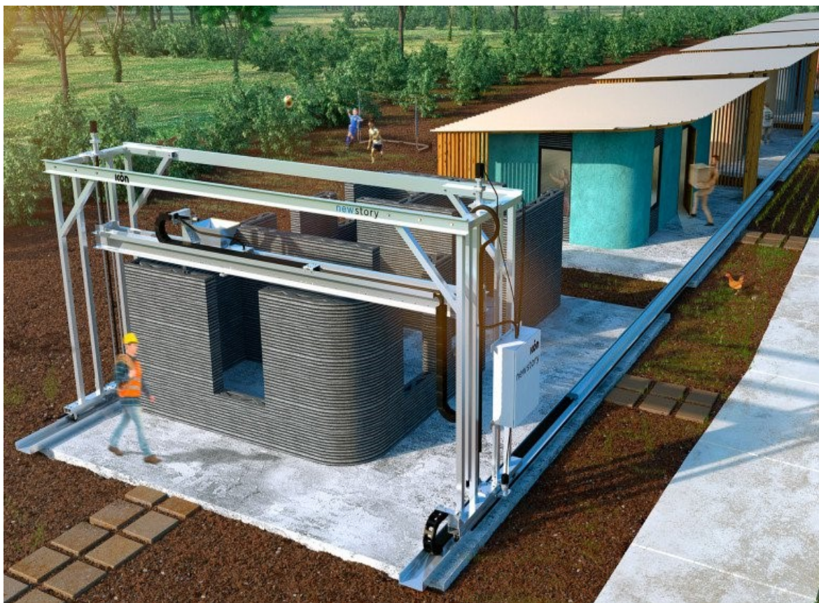
Obr. 2: Návrh 3D tiskárny na stavbu domů od společnosti ICON Vulcan [13]
