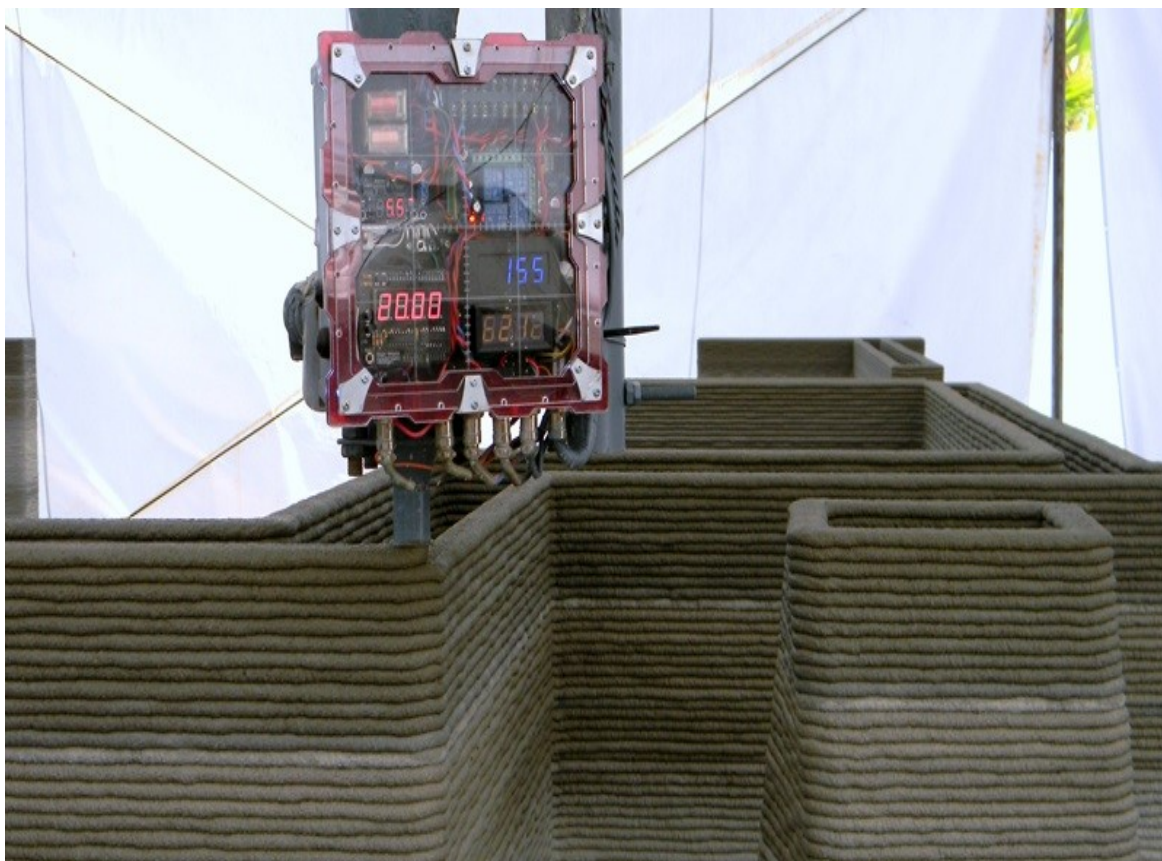
Obr. 3: 3D tisk domu – nanášení jednotlivých vrstev na sebe [14]
