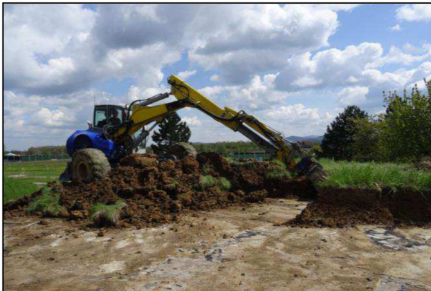
Obr. 8.15 Odstraňování vrstvy humusu ze střechy nad pravou akumulční komorou za použití bagru.
