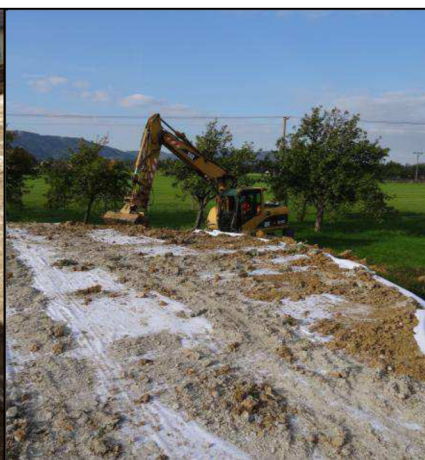
Obr. 8.18 V této fázi je skladba střechy dokončena. Vidíme položenou a zatíženou geotextilii.
