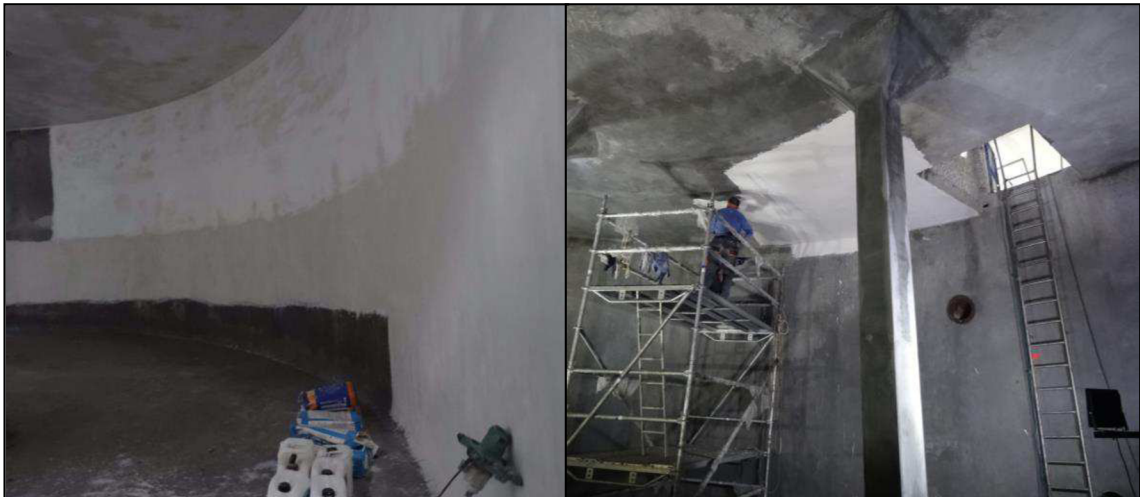
Obr. 8.12 Jednotlivé vrstvy sanačních hmot. Tmavá vrstva: malta Nanocret R3. Světlá vrstva: ochranný nátěr PCI Barraseal 2K.
