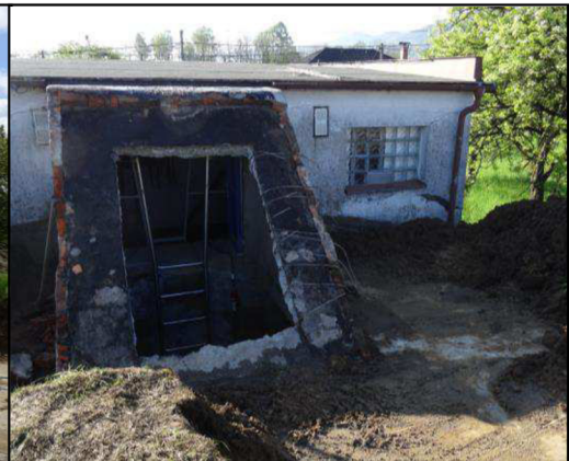
Obr. 8.16 Odkrytý vstup do pravé AN, demontáž a příprava na rekonstrukci šikmé střechy nad vstupem do nádrže.
