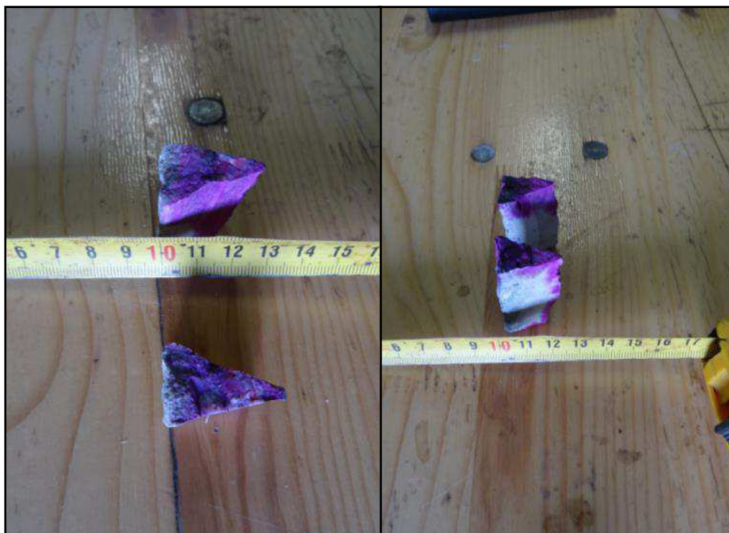
Obr. 5.1 Fenolftaleinový test karbonatce betonu. Rozlomený vzorek betonu postříkáme připraveným roztokem. Vrstvy zdravého (nezkarbonatovaného) betonu se zbarví do růžova až fialova, degradované vrstvy se vizuálně nezmění. Tyto vzorky pocházejí z pravé AK v Neborech.
