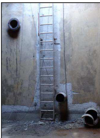
Obr. 8.22 Odřezané potrubí (zleva) bezpečnostního přelivu, přítoku a odběru uvnitř levé AN.
