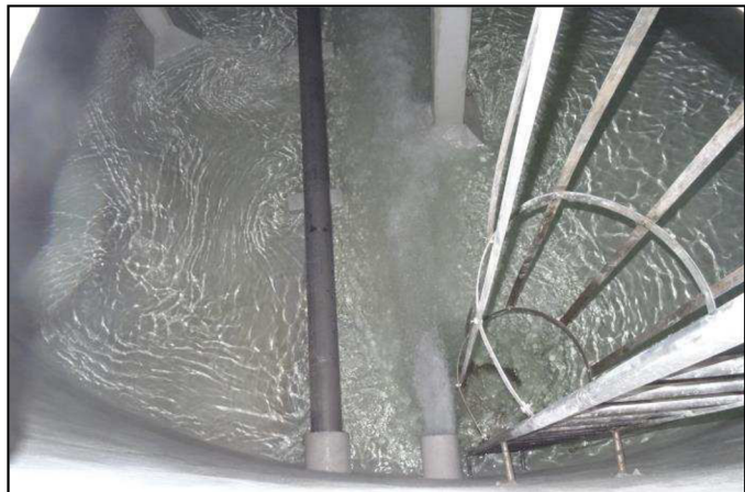
Obr. 8.30 Pohled do pravé akumulční nádrže během plnění při provádění zkoušky vodotěsnosti.
