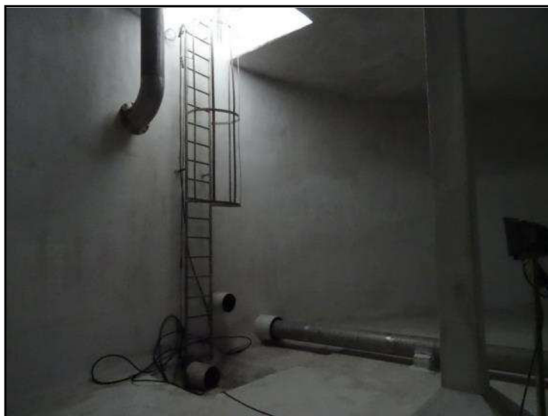
Obr. 8.25 Nové ocelové potrubí v sanované pravé nádrži.
