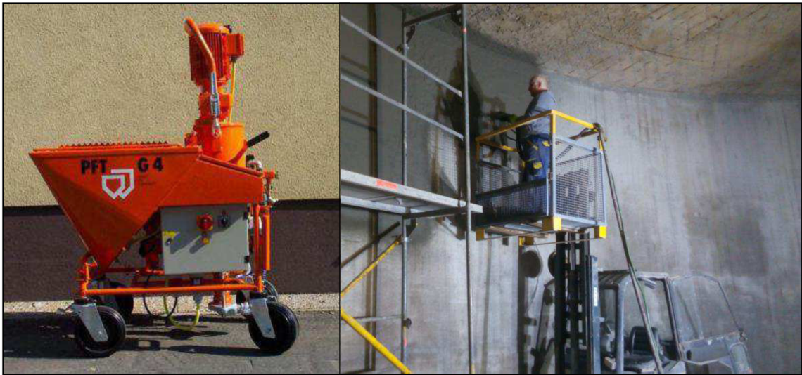
Obr. 8.11 Vlevo omítací stroj PFT G4. [14] Vpravo na fotografii jeho použití při reprofilaci povrchu. Strojní nanášení cementové sanační malty Nanocret R3.
