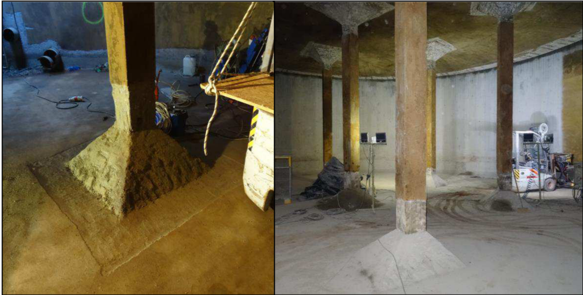
Obr. 8.9 Očištěná pata sloupu.
