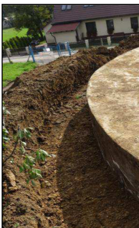
Obr. 8.17 Zemní práce. Lze vidět očištěný povrch AN.
