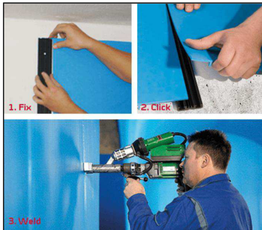
Obr. 4.4 V prvním kroku jsou černé lišty (= click profiles) mechanicky ukotveny do betonu. Ve druhém jsou desky (= sheets) HYDRO CLICK zacvaknuty (= clicked) do lišt. A ve třetím vidíme sváření dílů, kterým zajistíme vodotěsnost v místě styků dvou desek. [21]
