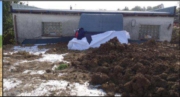
Obr. 8.21 Střecha nad vstupem do akumulární komory je obnovena, nad samotnou AN už probíhá zásyp zeminou.
