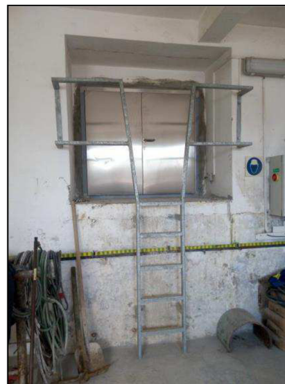
Obr. 8.27 Nové ocelové dvoukřídlé dveře před vstupem do pravé akumulací komory.
