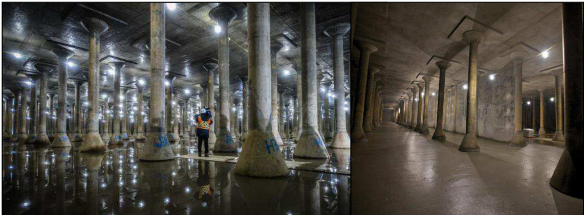
Obr. 4.2 Renovace zásobníku pitné vody v Montrealu stála 71 milionu dolarů. [28, 29]
