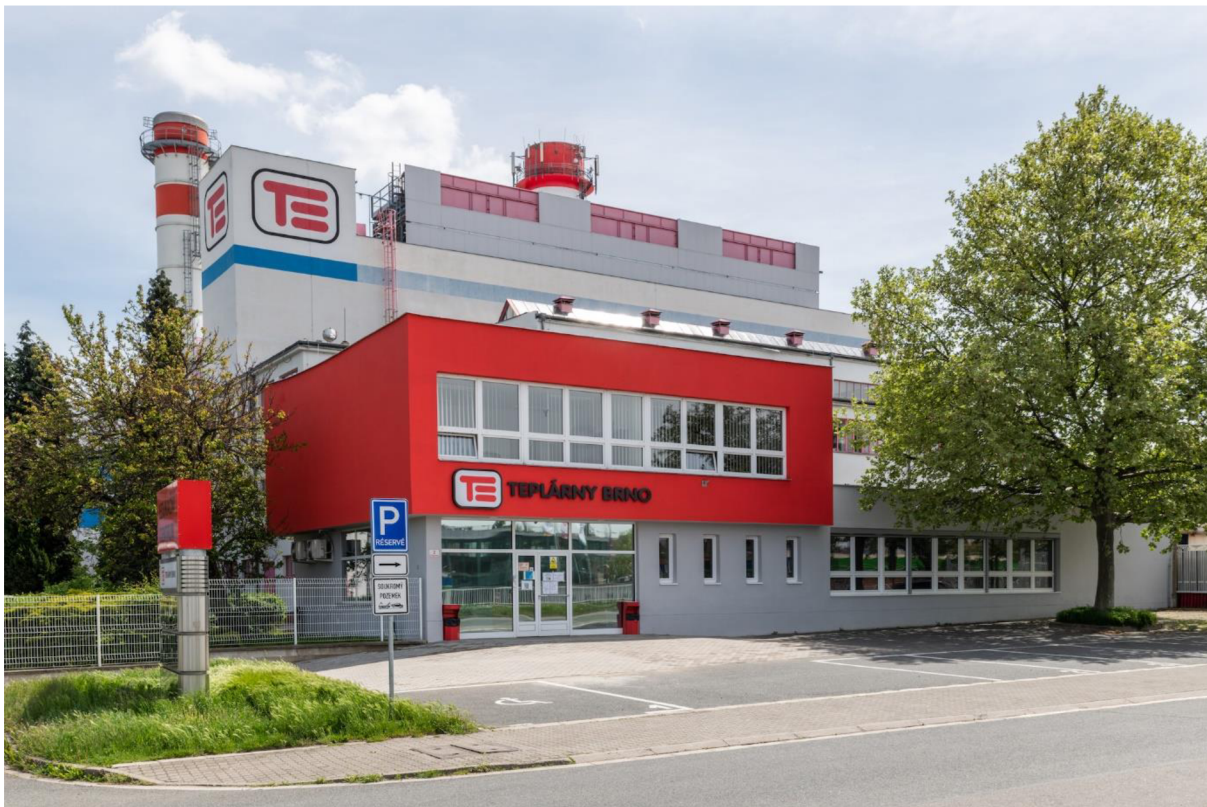
Obr. 2.1: Paroplynová teplárna Červený mlýn [30].
