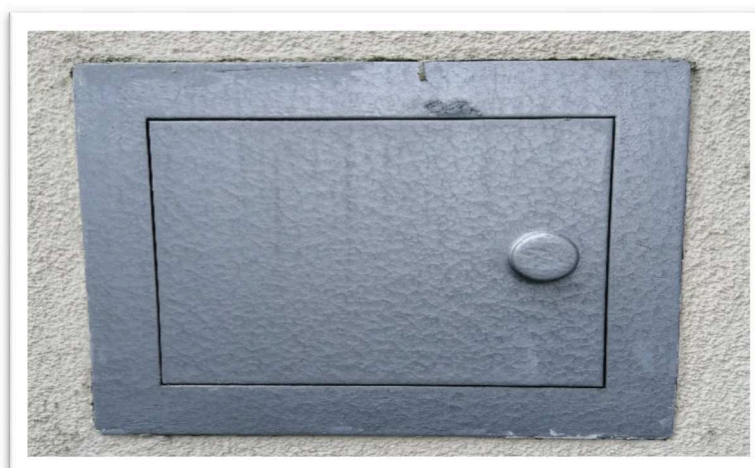
Obr. 4 – Klíčový trezor požární ochrany
