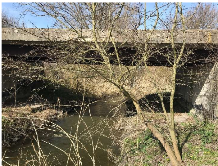
Obrázek 38 Pohled na přemostění na cestě C21 a vedení potoka
