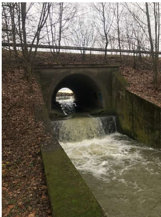
Obrázek 37 Parabolická výpusť na Štítarském potoce
