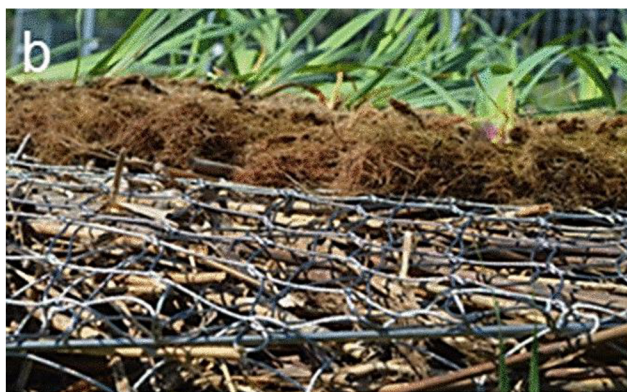
Obrázek 2: Detail konstrukce z ocelové sítě vyplněné rákosem (URL 2).
