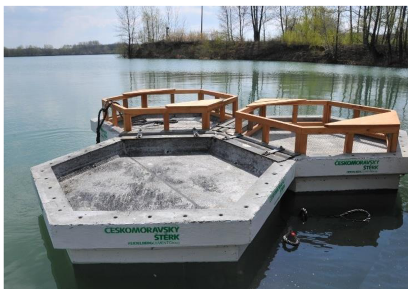
Obrázek 4: Stavba umělého plovoucího ostrova z betonových konstrukcí (URL 4).
