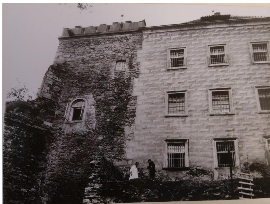
30. obr. Želiv, Trčkův hrad, severní strana, stav před opravou roku 1964.
