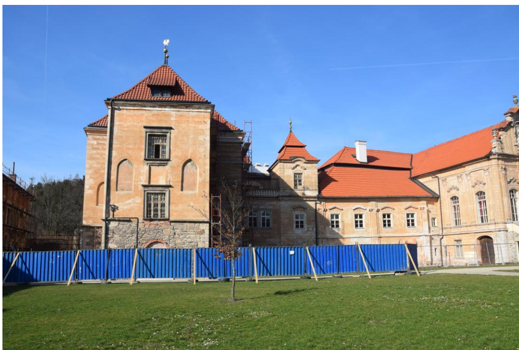
4. obr. Želiv, Trčkův hrad, pohled na průčelí při rekonstrukci roku 2019.
