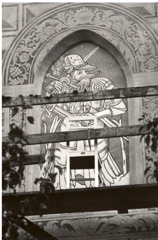
15. obr. Želiv, Trčkův hrad, jižní průčelí, sgrafitová výzdoba, stav po restaurování roku 1965.
