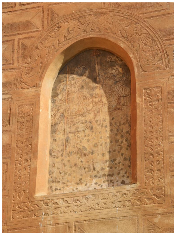
19. obr. Želiv, Trčkův hrad, jižní strana, figurální sgrafito, stav před restaurováním roku 2018.
