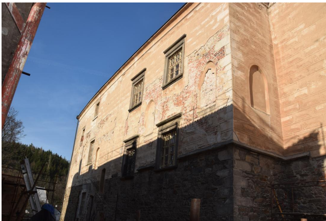
5. obr. Želiv, Trčkův hrad, pohled na západní fasádu při rekonstrukci roku 2019.
