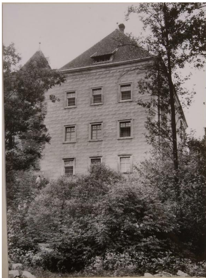
29. obr. Želiv, Trčkův hrad, severní strana, stav před opravou roku 1964.
