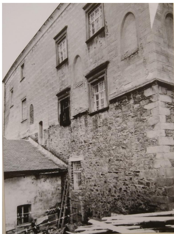
28. obr. Želiv, Trčkův hrad, západní strana, stav před opravou roku 1964.
