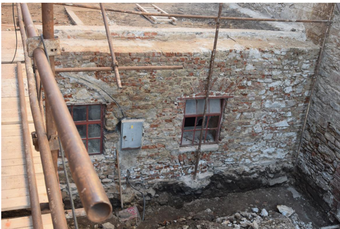
6. obr. Želiv, Trčkův hrad, pohled na spojovací přístavek při rekonstrukci roku 2019.
