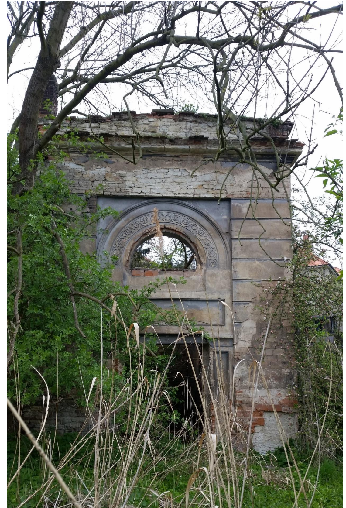
Obr. 25: Západní předsíň, nahoře pokoj pomocníka (Zdroj: Vlastní fotodokumentace, 2017)
