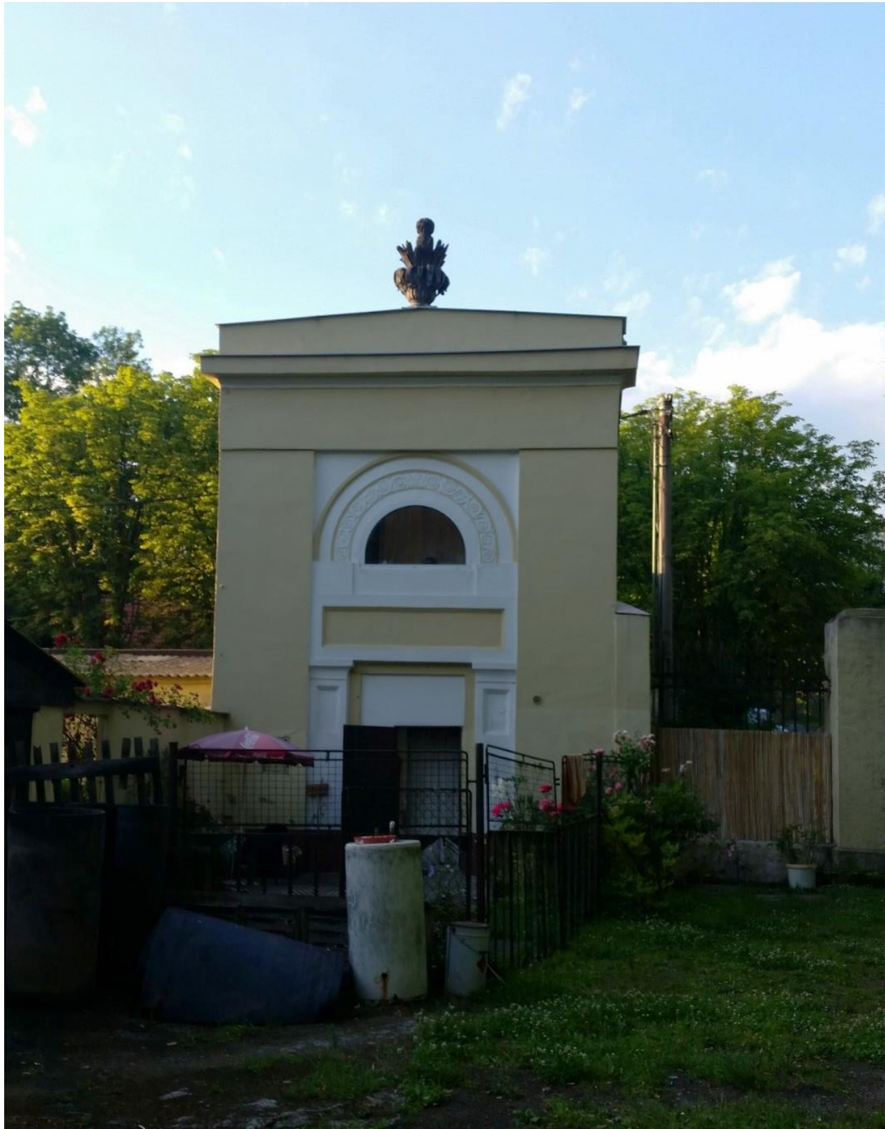
Obr. 26: Rekonstruovaná východní předsíň zámecké oranžerie (Zdroj: Vlastní fotodokumentace, 2017)
