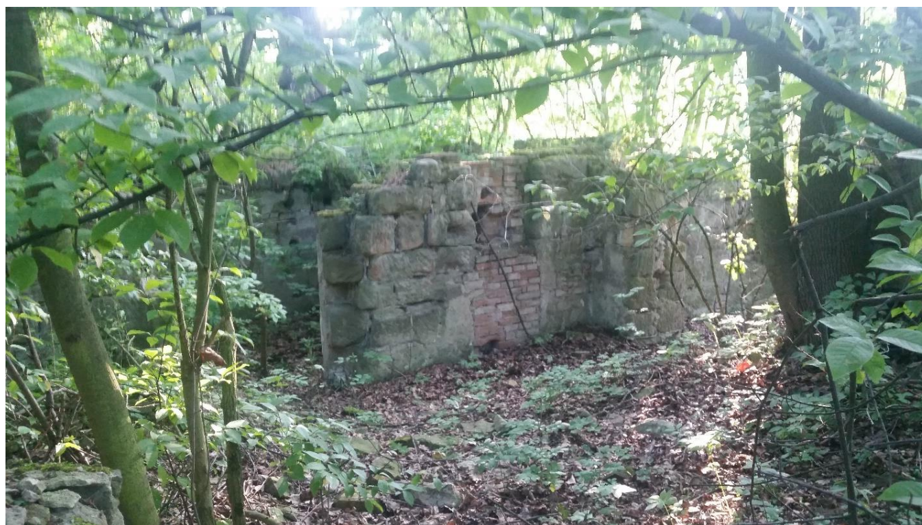
Obr. 30: Pozůstatky sušárny ovoce (Zdroj: Vlastní fotodokumentace, 2017)
