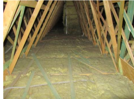
Obr. 84 Zateplení stropní konstrukce mezi trámy
