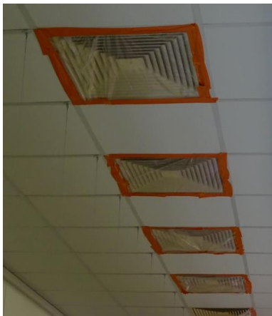
Obr. 28 Utěsnění nuceného větrání - odvodu vzduchu v prodejně
