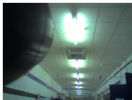
Obr. 48 Reálný snímek z místa vytvoření termogramu - sklad
