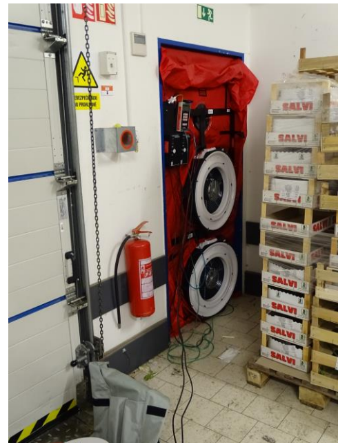
Obr. 31 Blower-door test - ventilátory 2/5 - interiér (Sklad)
