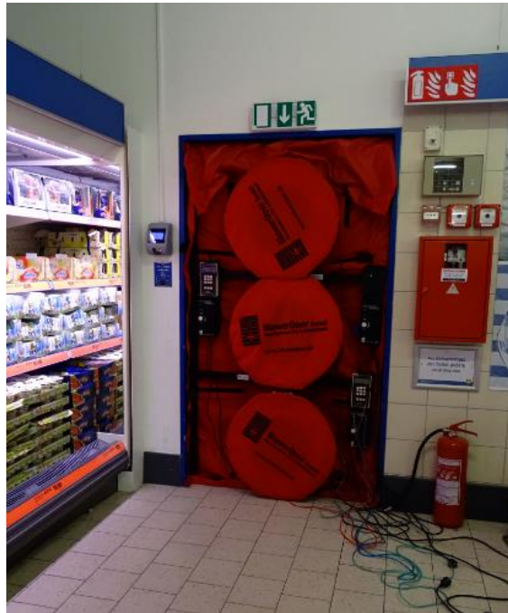
Obr. 34 Blower-door test - měření základního tlakového rozdílu (Baseline)
