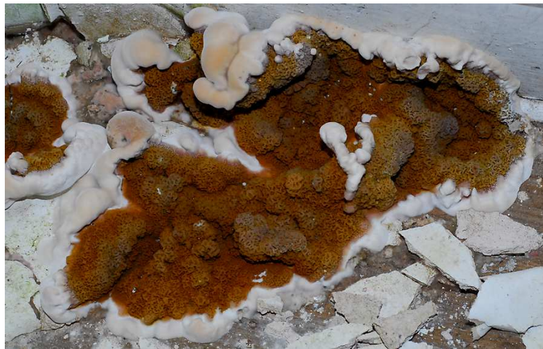
Obr. 7: Dřevomorka domácí ( Serpula lacrymans ) [18]
