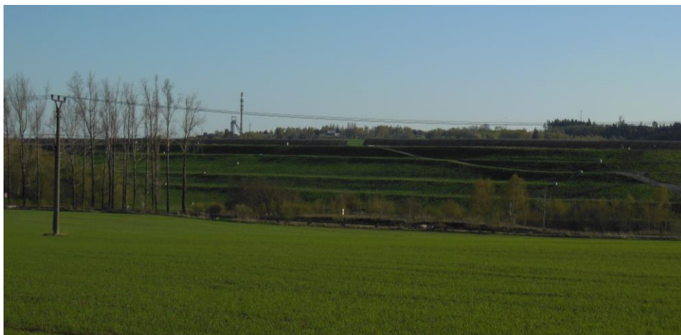
Vnější stupňovité terasování svahu hráze odkaliště odpadu chemické úpravny (zdroj: vlastní 2016)
