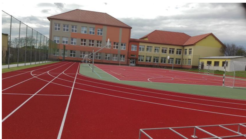
Víceúčelové sportovní hřiště a ZŠ T. G. M. v Bystřici n. P. (zdroj: vlastní 2016)
