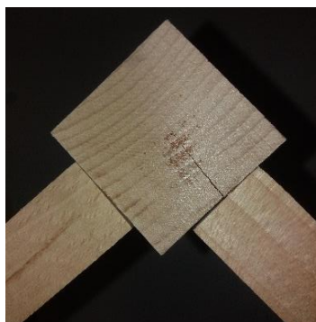
Obrázek 34 Prasklina na čelní straně sloupku.
