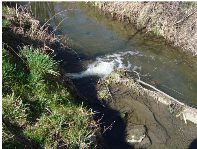
Obr. č. 17: Vyústění výpusti do koryta vodního toku Úmoří za obcí Skalice nad Svitavou (foto: Jurečková Anna)
