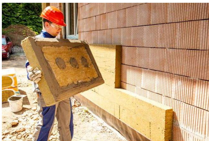
Obr. 25 Lepení izolantu
