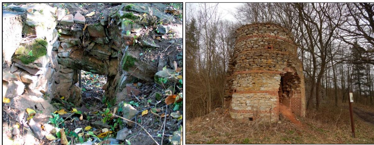
Obr. 10 Domácí selská vápencová pec v Blažově – pohled na peciště, zdroj: Papoušek M., online
