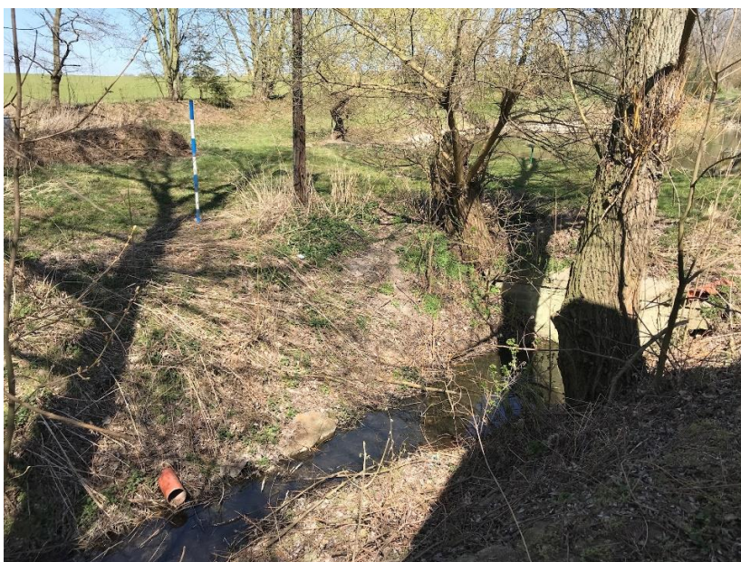
Obr. č. 36 – Zaústění drenáže odvodněné plochy do bezejmenného toku
