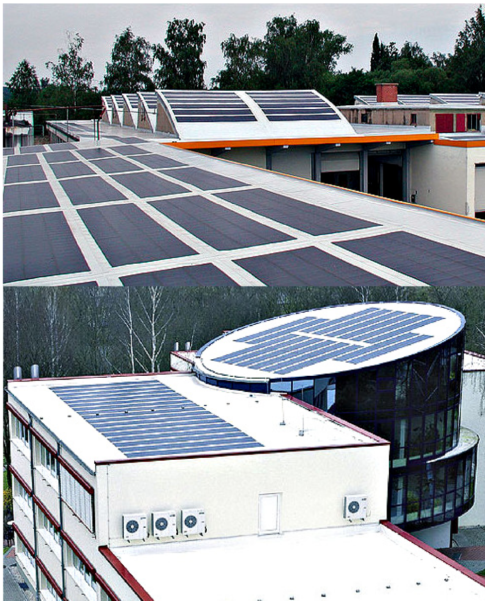
obr. 13 Ploché střechy s integrovaným fotovoltaickým systémem EVALON-Solar
