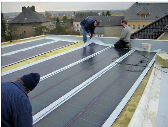
obr. 16 Pokládání pásů EVALON V-Solar s integrovanými fotovoltaickými články
