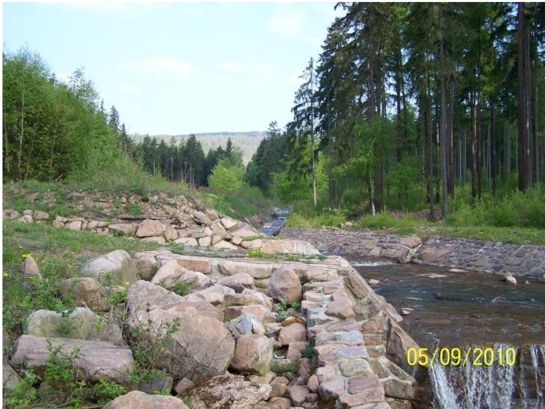
Foto č. 7: Bystřice - příčné prahy, stupně
