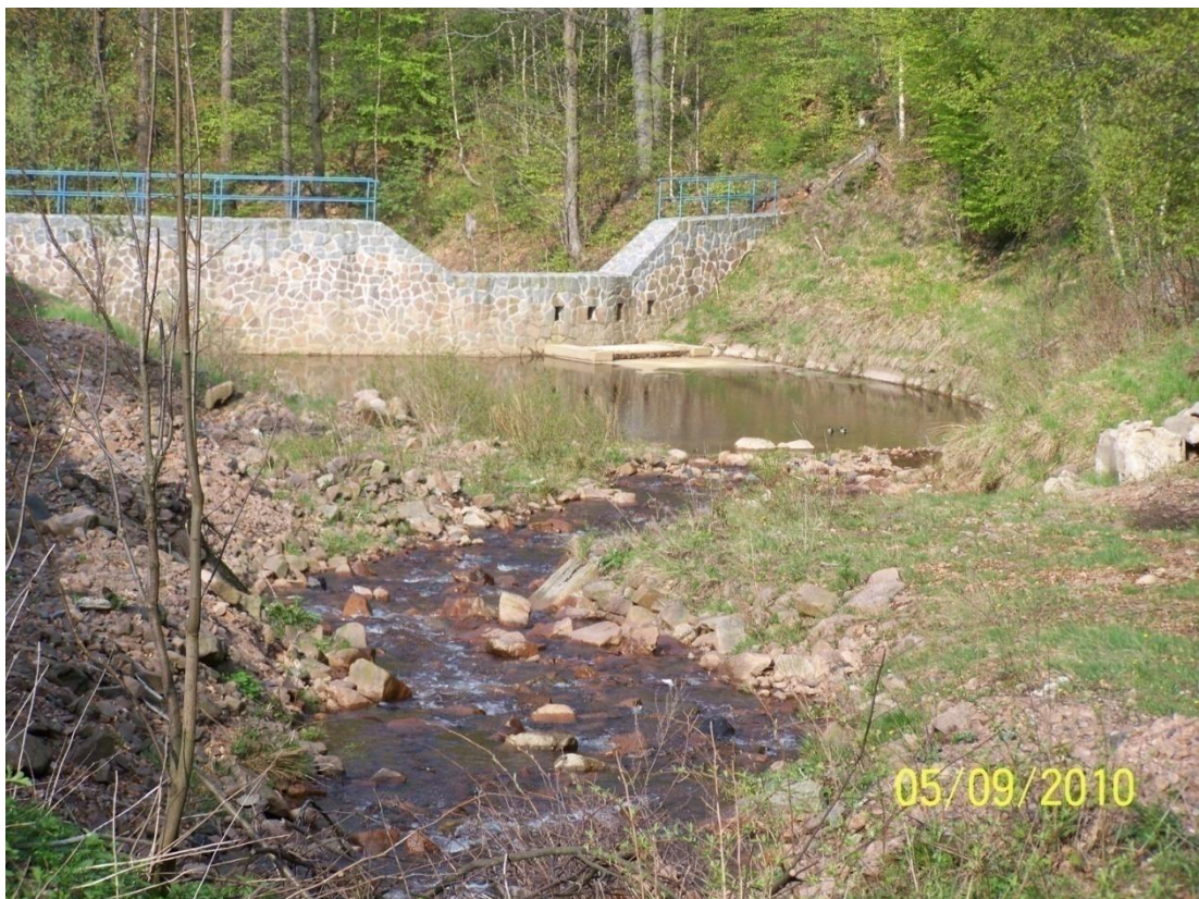
Foto č. 6: Retenční přehrážka III
