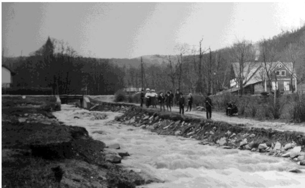
Foto č. 1: Bystřice - staré koryto potoka
