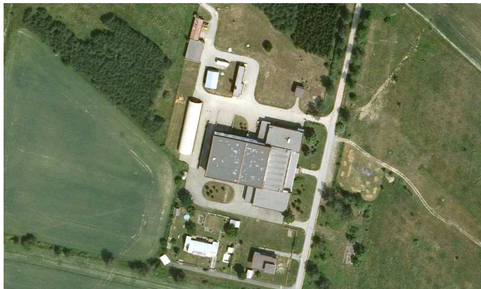
Obr. 4.19 Úpravna vody Hrobice [33]
