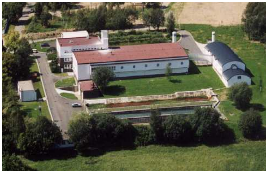
Obr. 4.8 Úpravna vody Hosov [32]
