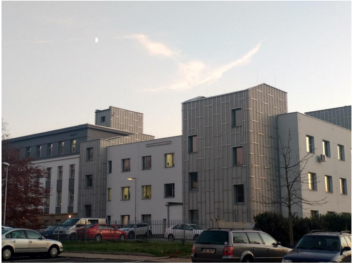
Budova úřadu práce (zdroj: Anna Thieleová)
