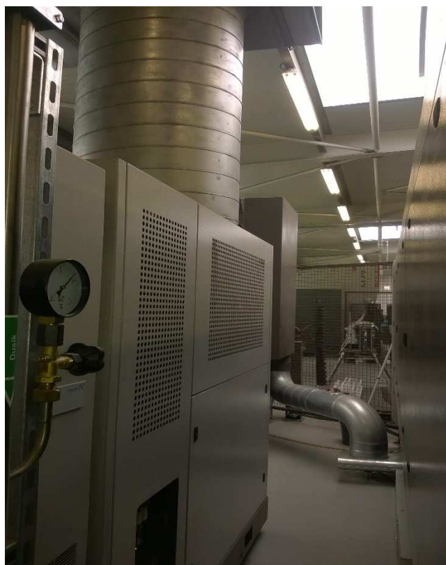
Obr 3.4 Systém odsávání z komory laseru
