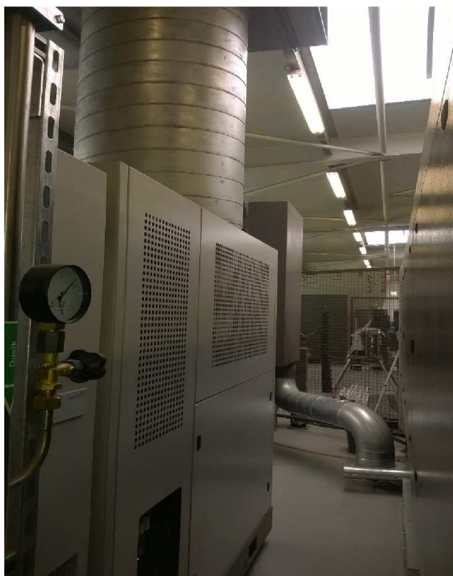
Obr 3.4 Systém odsávání z komory laseru
