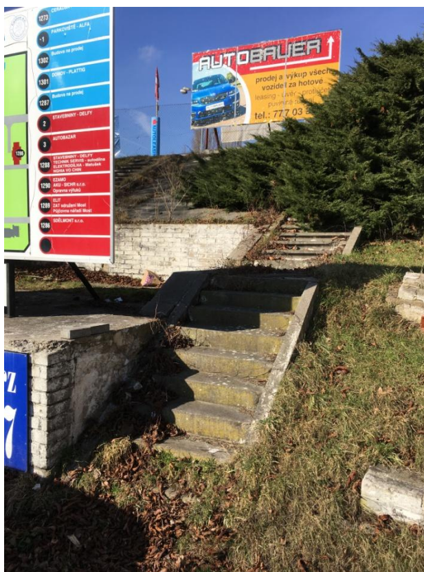
Obr. č. 22: Schody vedoucí přímo do keře
