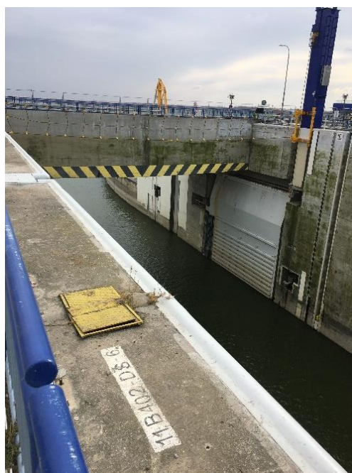
Obr. 18 Dolní vrata komory s mostovkou komunikace 1)
