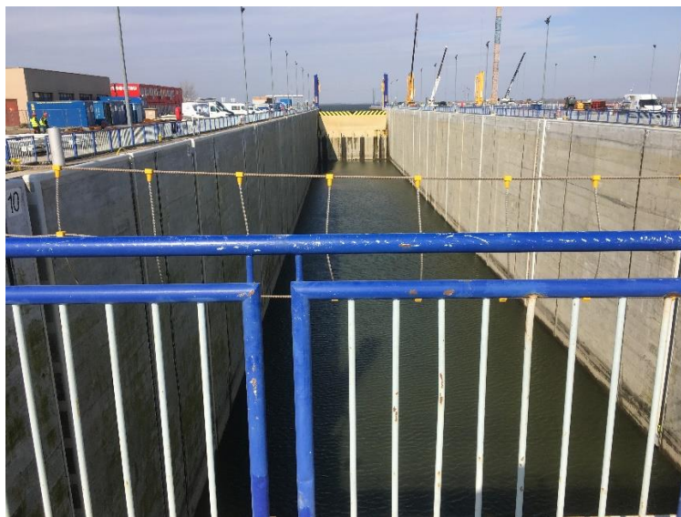
Obr. 13 Pohled do plavební komory VD Gabčíkovo 1)
