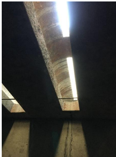
Obr. 16 Pohled do ocelové trubky průměru 1,5m z prostředního kanálu 1)
