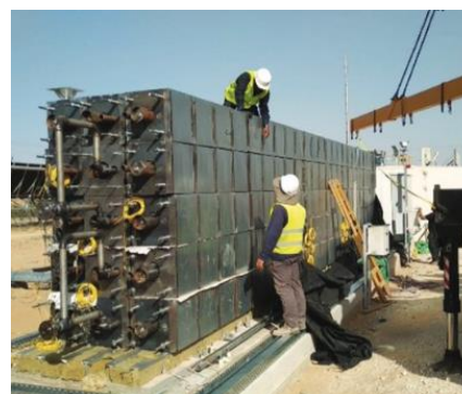
Obrázek 21: Ukázka jednotlivých modulů s nadrceným kamenem. [30]
