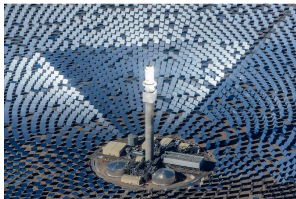
Obrázek 29: Elektrárna Crescent Dunes [46]
