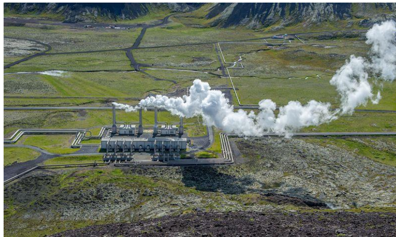
Obr. 6 Geotermální elektrárna Nesjavellir, druhá největší na Islandu [17]
