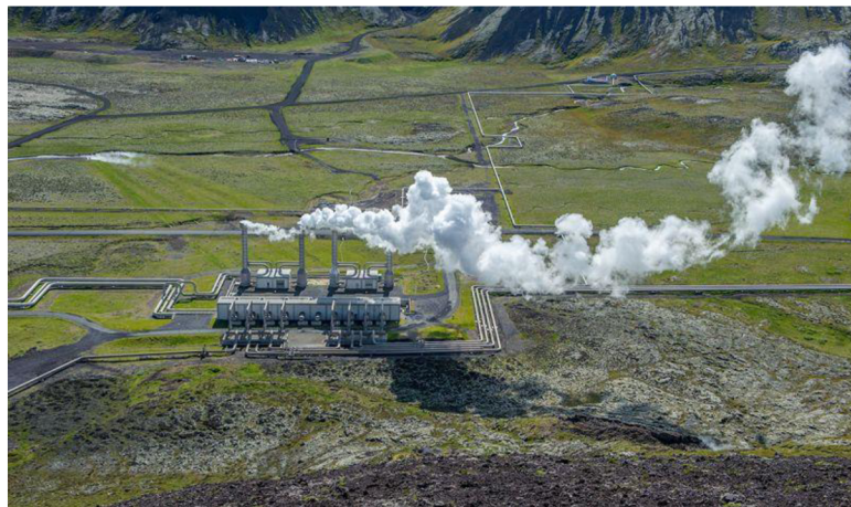
Obr. 6 Geotermální elektrárna Nesjavellir, druhá největší na Islandu [17]
