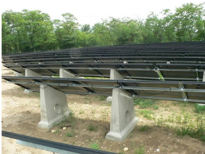
Obrázek 8: Konstrukce fotovoltaické elektrárny ve Vojkovicích je podobná jako u elektrárny v Jaroslavicích [22]
