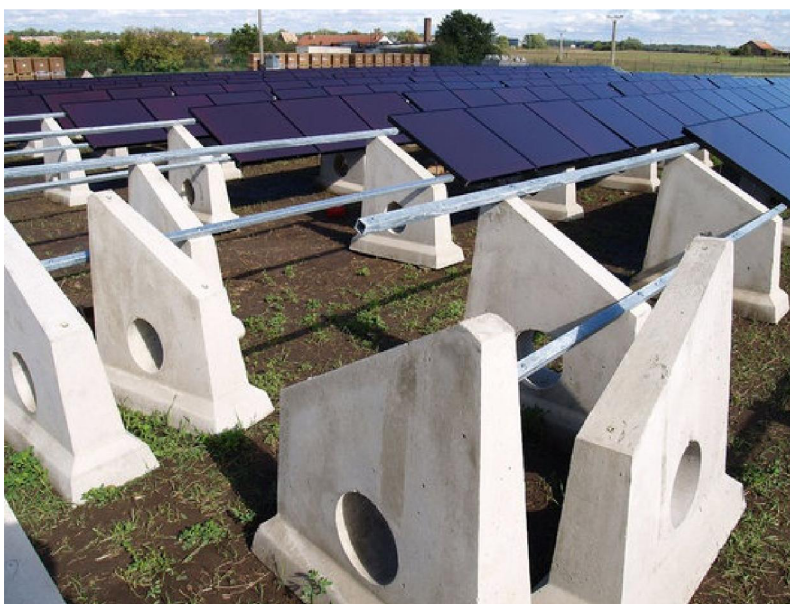
Obrázek 7: Detail betonových nosníků FV panelů elektrárny v Jaroslavicích [21]
