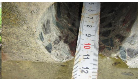
Obr. 33 – Detailní foto měření hloubky jádrového vývrtu sondy V3 [12]
