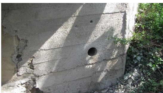
Obr. 45 – Celkový pohled na levou opěru s vývrtem V6 [12]
