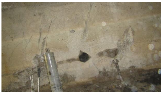
Obr. 41 – Celkový pohled na pravou opěru s vývrtem V5 [12]
