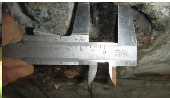
Obr. 59 – Ověření průměru žebírkové výztuže nosníku v sondě SV1 [12]
