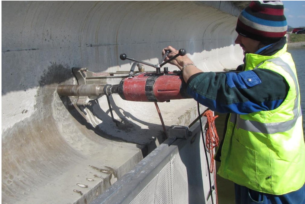
Obr. 7 – Zařízení pro odběr jádrových vývrtů [12]
