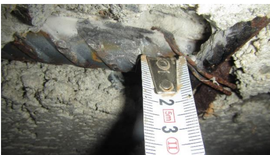
Obr. 62 – Detailní pohled měření krytí dolní výztuže v sondě SV2 [12]
