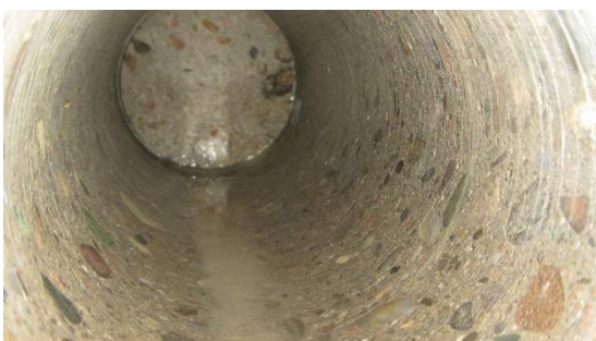
Obr. 47 – Detailní foto ostění vývrtní sondy V6 po vyjmutí návrtního nástroje [12]
