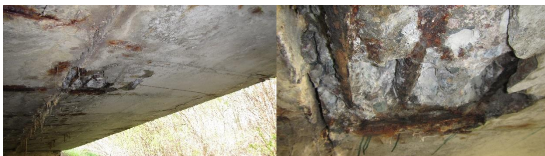
Obr. 56 – Celkový pohled na místo provedení sekané sondy SV1 [12]
