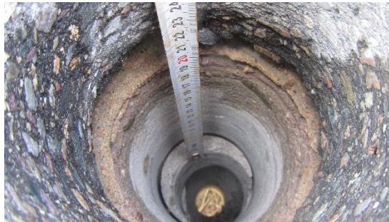
Obr. 53 – Detailní pohled na jednotlivé vrstvy ostění sondy SK1 [12]
