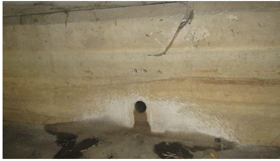
Obr. 37 – Celkový pohled na levou opěru s vývrtem V4 [12]
