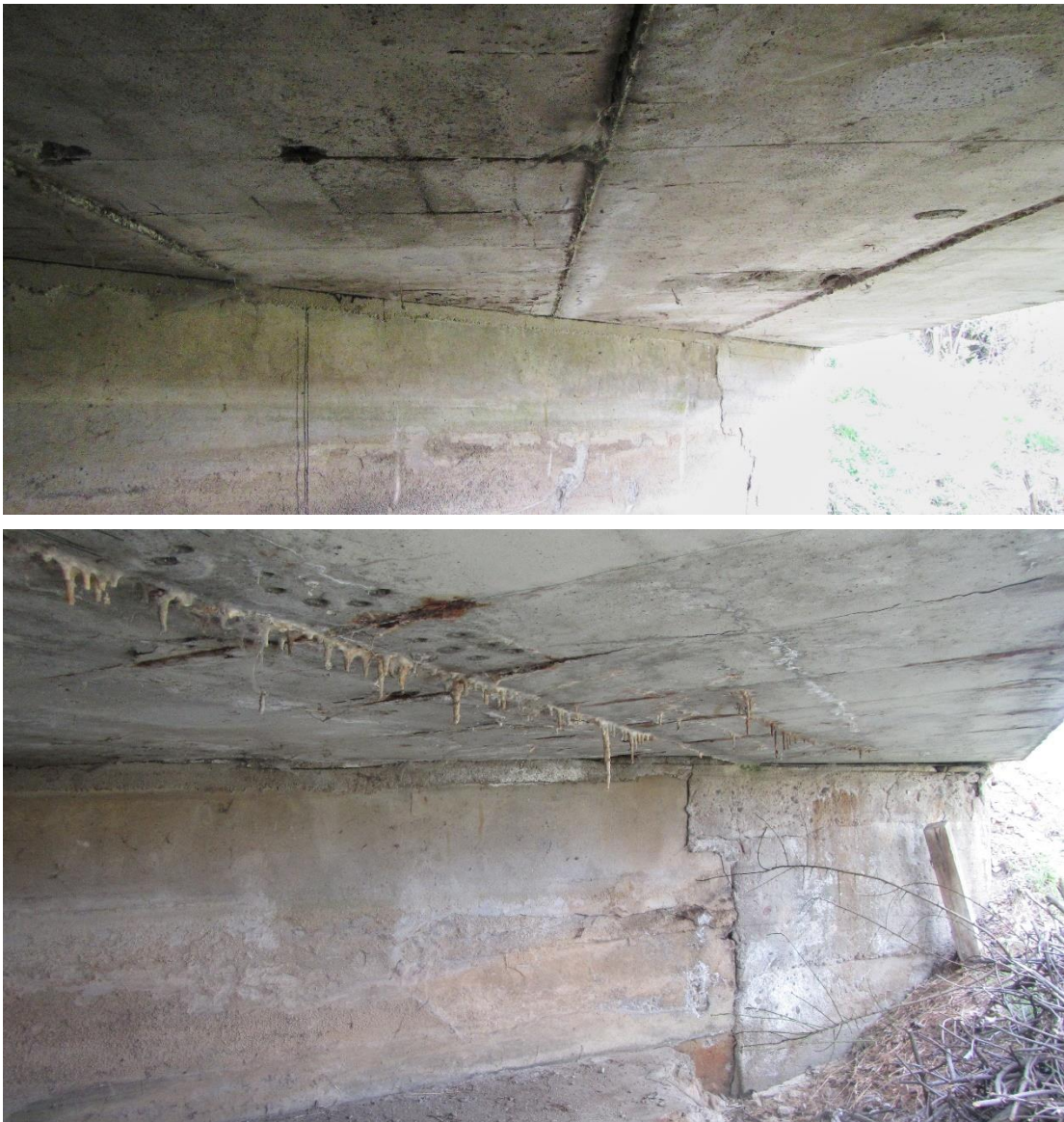
Obr. 22 – Pohled na spodní líc nosné konstrukce [12]
