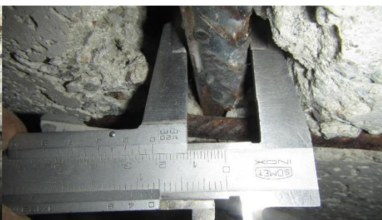
Obr. 63 – Ověření průměru žebírkové výztuže nosníku v sondě SV2 [12]
