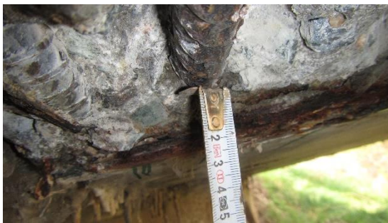
Obr. 58 – Detailní pohled měření krytí dolní výztuže v sondě SV1 [12]
