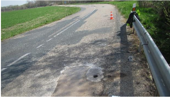
Obr. 51 – Celkový pohled na provedené místo sondy SK1 [12]
