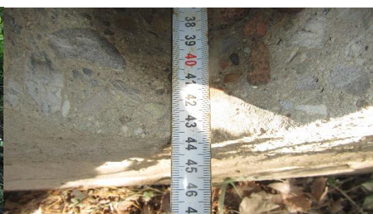
Obr. 46 – Detailní foto měření hloubky jádrového vývrtní sondy V6 [12]
