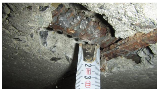
Obr. 66 – Detailní pohled měření krytí dolní výztuže v sondě SV3 [12]
