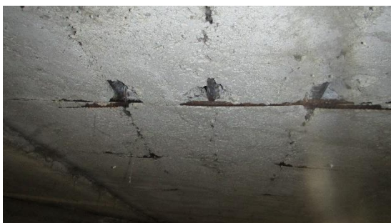
Obr. 60 – Celkový pohled na místo provedení sekané sondy SV2 [12]
