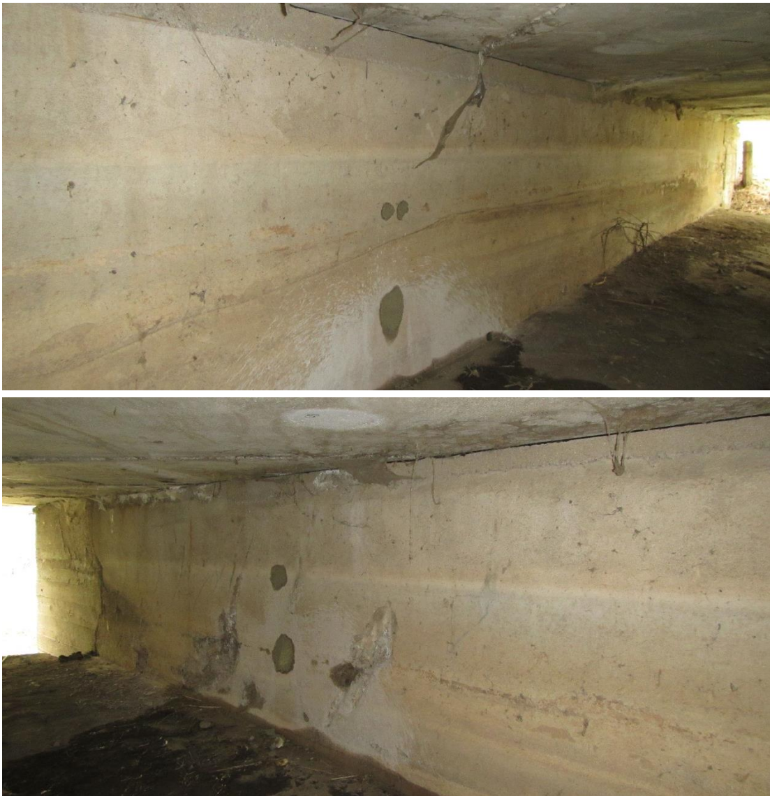
Obr. 21 - Pohled na opěru 1 a 2 [12]
