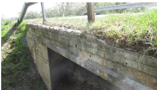
Obr. 32 – Celkový pohled na místo provedení jádrového vývrtu V3 [12]
