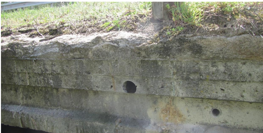
Obr. 25 – Pohled na římsu s vegetací a krápníky [12]
