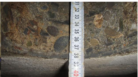
Obr. 42 – Detailní foto měření hloubky jádrového vývrtní sondy V5 [12]
