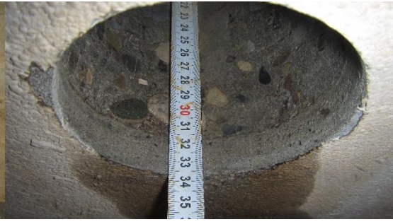
Obr. 38 – Detailní foto měření hloubky jádrového vývrtní sondy V4 [12]
