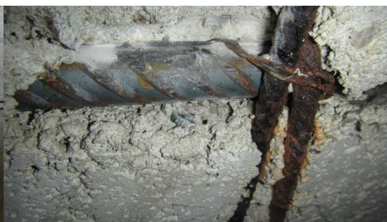
Obr. 61 – Detailní pohled na sekanou sondu uprostřed rozpětí nosníku SV2 [12]
