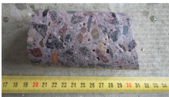
Obr. 30 – Laboratorní foto odebraného vzorku betonu ze sondy V1 [12]
