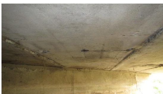
Obr. 64 – Celkový pohled na místo provedení sekané sondy SV3 [12]
