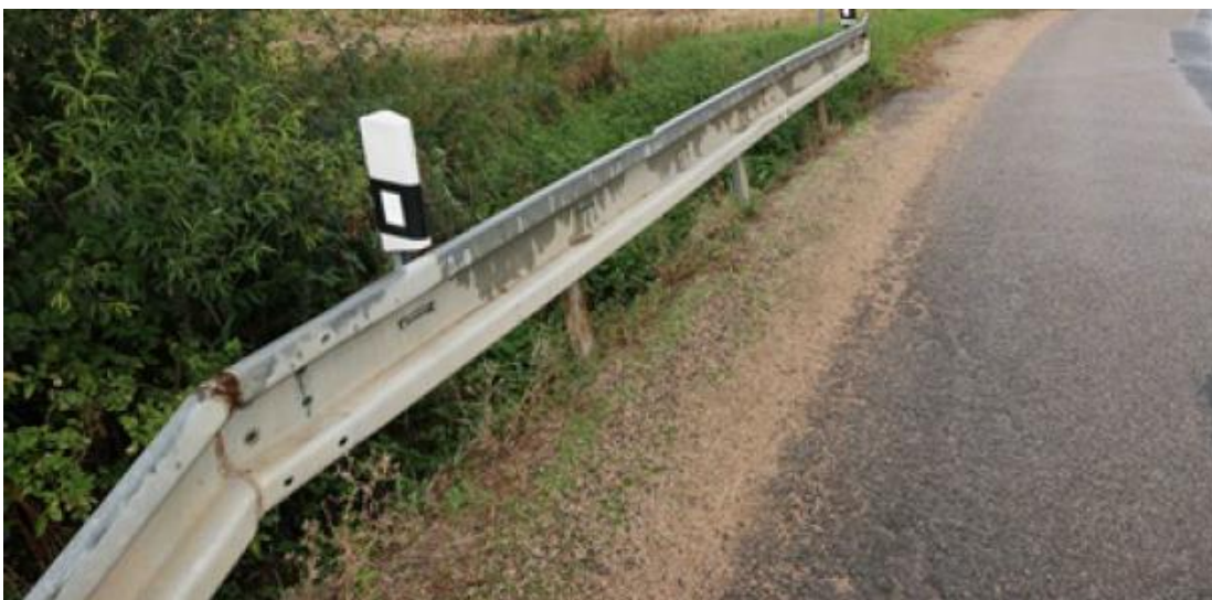
Obr. 26 – Pohled na záchytné zařízení [12]
