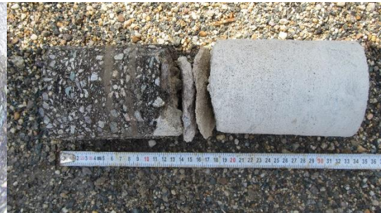
Obr. 54 – Detailní pohled na skladbu vozovky SK1 [12]
