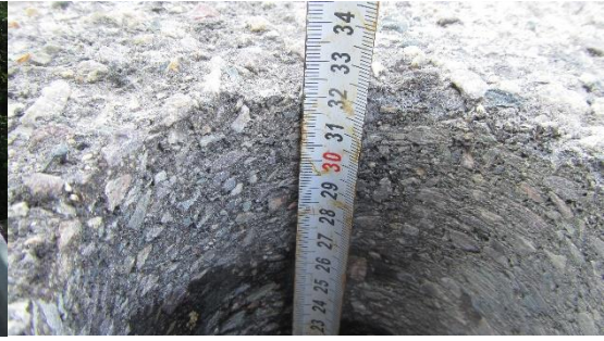
Obr. 52 – Měření tloušťky vozkových vrstev od horního líce nosné konstrukce [12]
