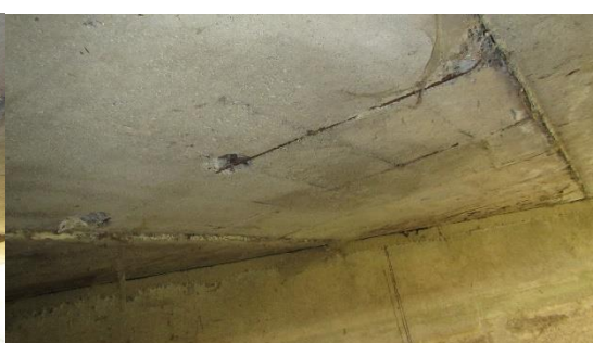
Obr. 65 – Detailní pohled na sekanou sondu uprostřed rozpětí nosníku SV3 [12]
