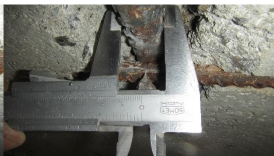
Obr. 67 – Ověření průměru žebírkové výztuže nosníku v sondě SV3 [12]
