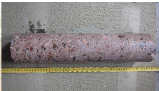
Obr. 48 – Laboratorní foto odebraného vzorku betonu ze sondy V6 [12]
