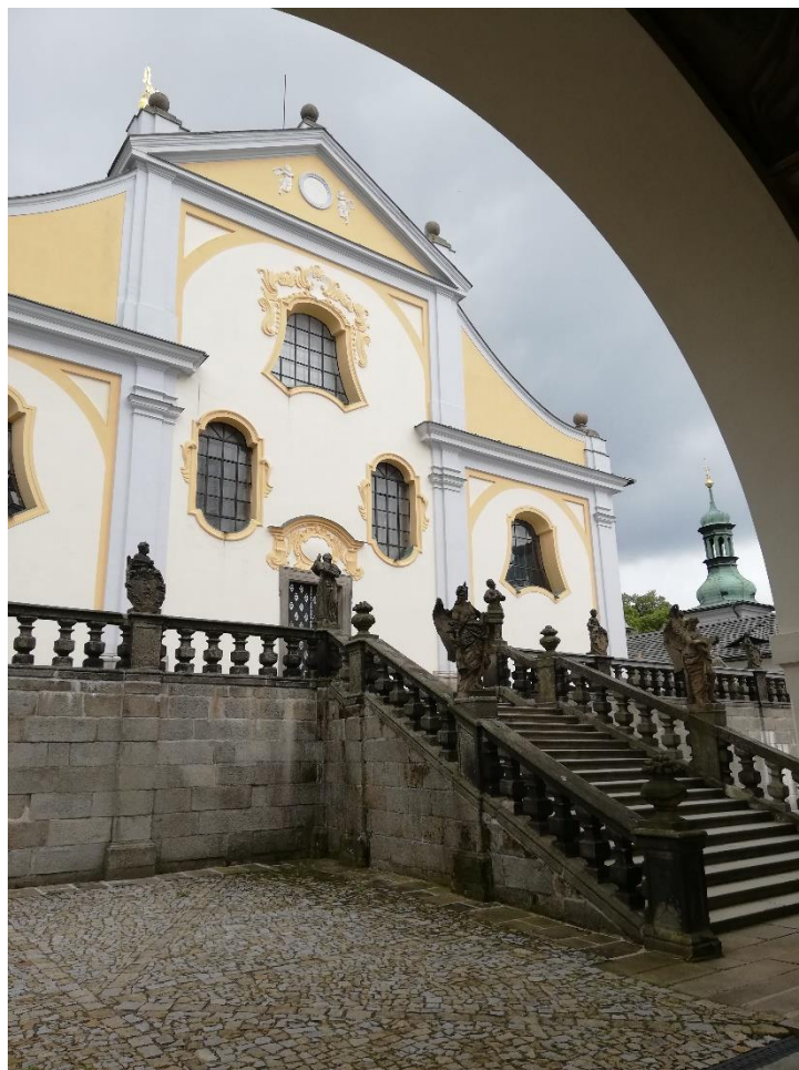
Obr. 25: Pohled na schodiště a západní stranu terasy
