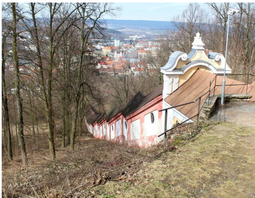
Obr. 35: Pohled na Svatohorské schody
