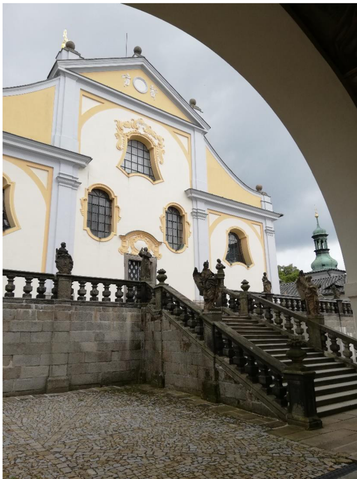
Obr. 25: Pohled na schodiště a západní stranu terasy
