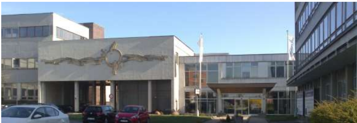
Obrázek 22 – pobočka Johnson Controls ve Strakonících [0]
