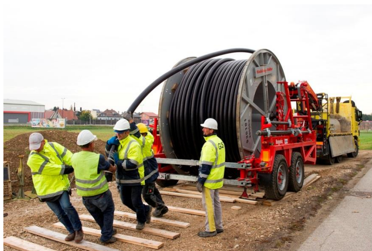
Obr. B-1 – Pokládka kabelu VVN [6]
