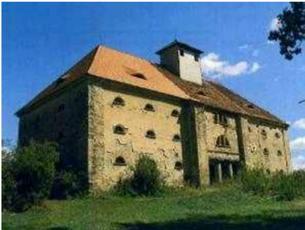
Obrázek 1 Kontribuční sýpka v Blatné před rekonstrukcí
