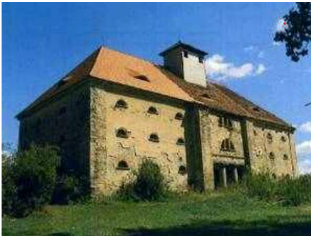
Obrázek 1 Kontribuční sýpka v Blatné před rekonstrukcí
