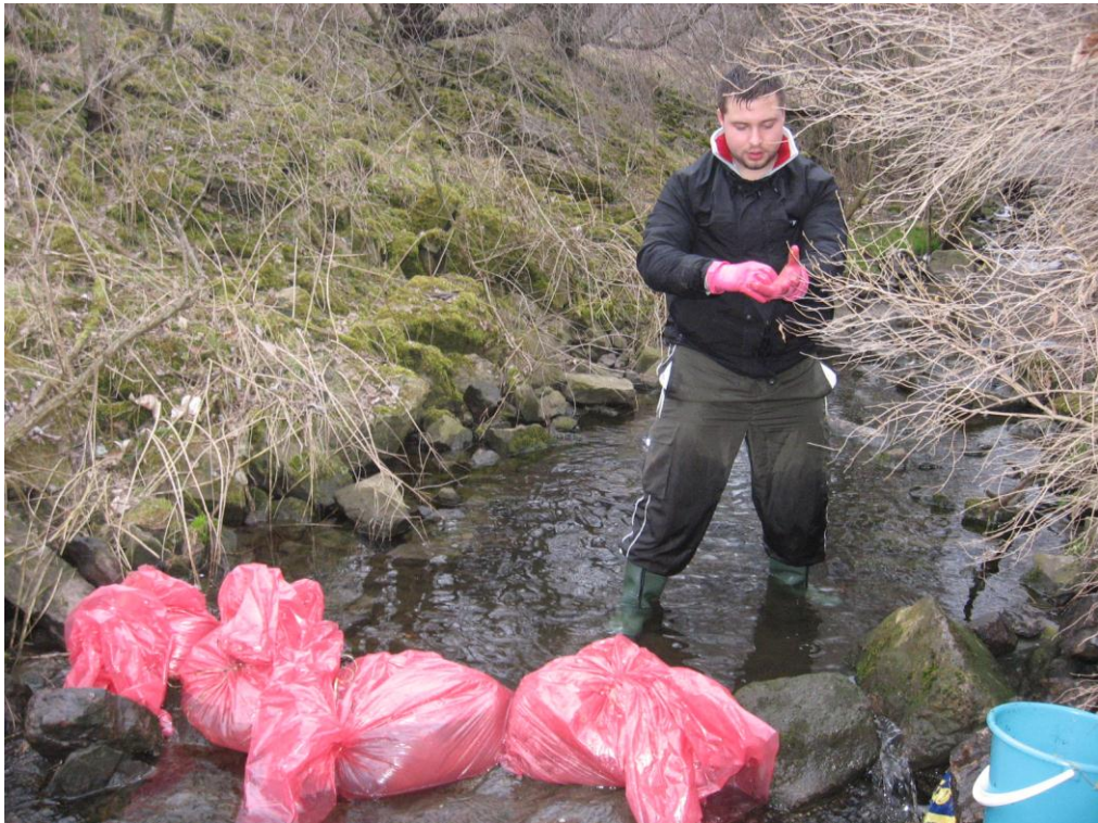
Obrázek č. 5: Hráz z pytlů s pískem na Prokopském p.
