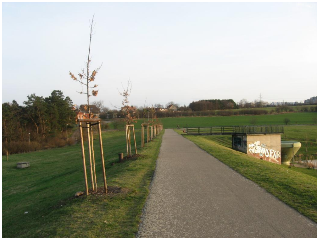
Obrázek č. 21: Hráz na nádrži N3 Asuán se stromovou alejí
