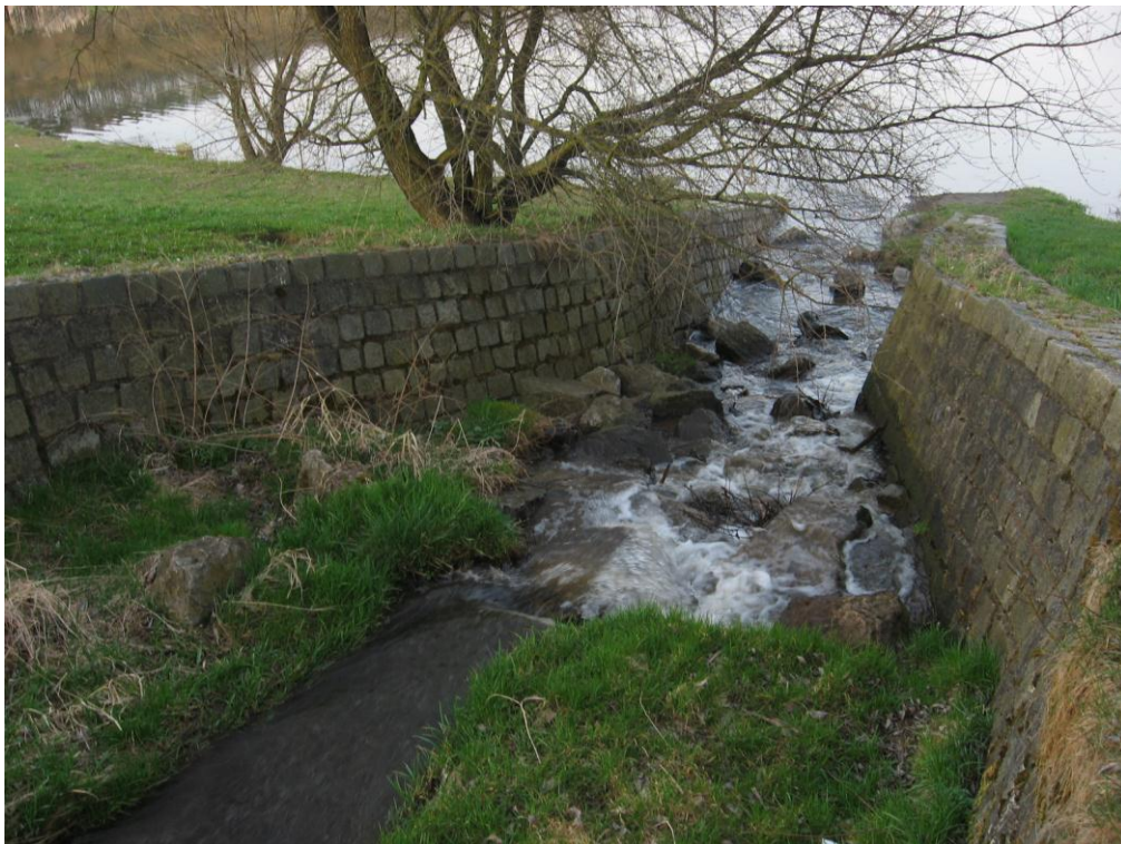
Obrázek č. 15: Přítok Prokopského p. do nádrže N3 Asuán
