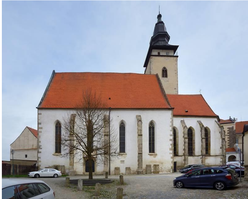
27. Telč, kostel sv. Jakuba, pohled od jihu, druhá polovina 14. století.
