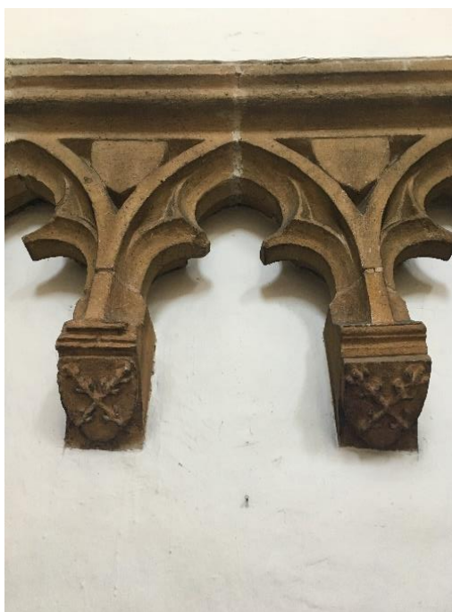
12. Letovice, kostel sv. Prokopa, presbytář – jižní stěna, detail sedile, poslední čtvrtina 14. století.
