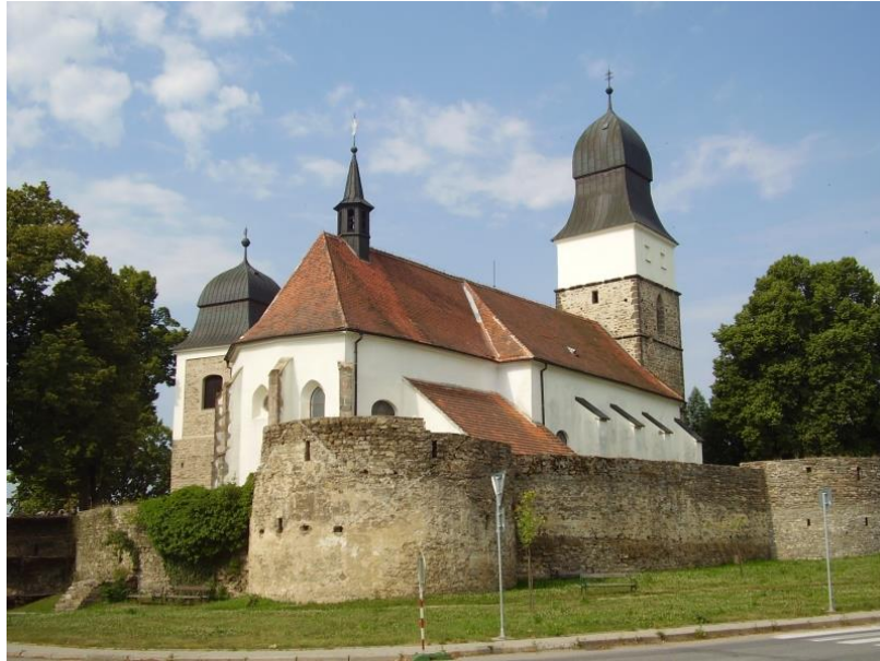
26. Velká Bíteš, kostel sv. Jana Křtitele, pohled od severovýchodu, polovina 14. století.
