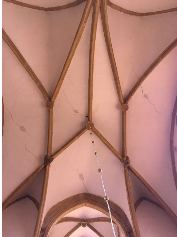
20. Letovice, kostel sv. Prokopa, kaple Panny Marie, klenba se svorníky, poslední čtvrtina 14. století.
