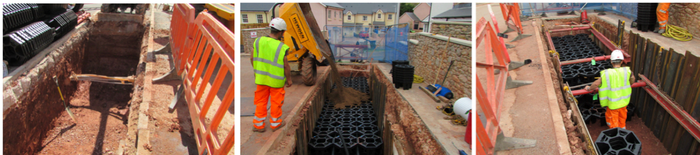
Obr. XIX Prokořenitelné buňky v Doveru (zdroj: bluegreen.com )
