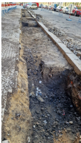
Obr. XVIII. Prokořenitelné zemní buňky TreeParker (zdroj: TSK Praha)
