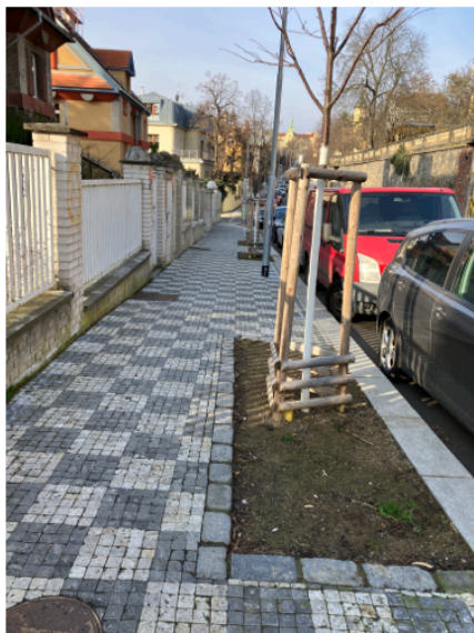
Obr. XXIV. Žulové kostky a osazení je do vhodných materiálů tvořící šedou infrastrukturu (zdroj: vlastní foto)
