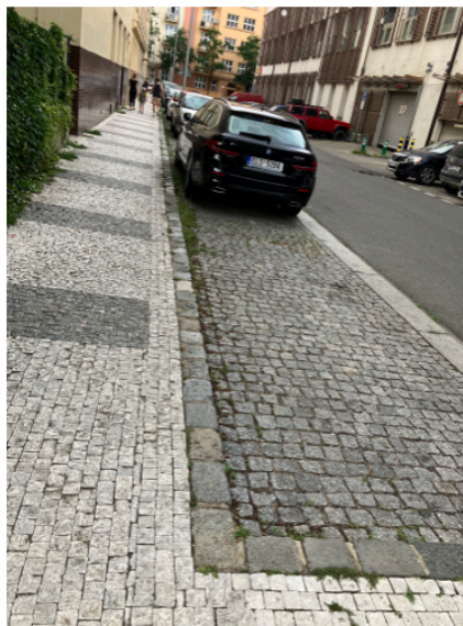
Obr. XXIV. Žulové kostky a osazení je do vhodných materiálů tvořící šedou infrastrukturu (zdroj: vlastní foto)
