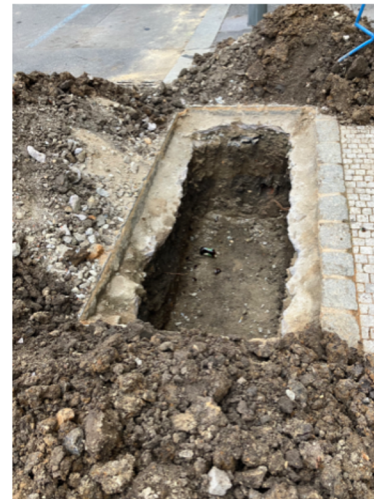
Obr. XXI. Kořenové jámy pro výsadbu do strukturálního substrátu (zdroj: vlastní foto)
