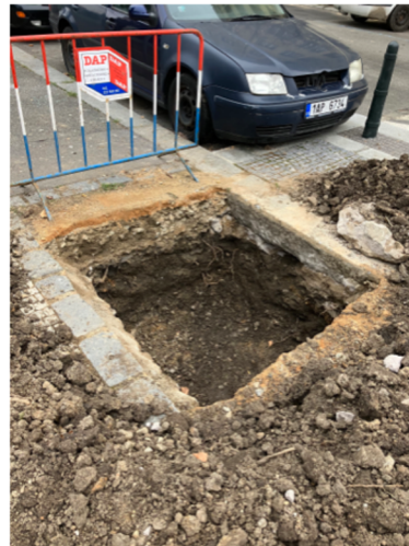
Obr. XXI. Kořenové jámy pro výsadbu do strukturálního substrátu (zdroj: vlastní foto)
