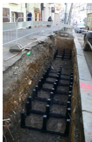
Obr. XVIII. Prokořenitelné zemní buňky TreeParker (zdroj: TSK Praha)
