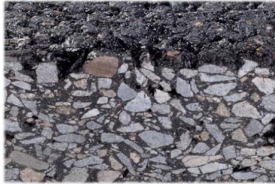
Obr. 6 Asfaltová směs SMA [8]
