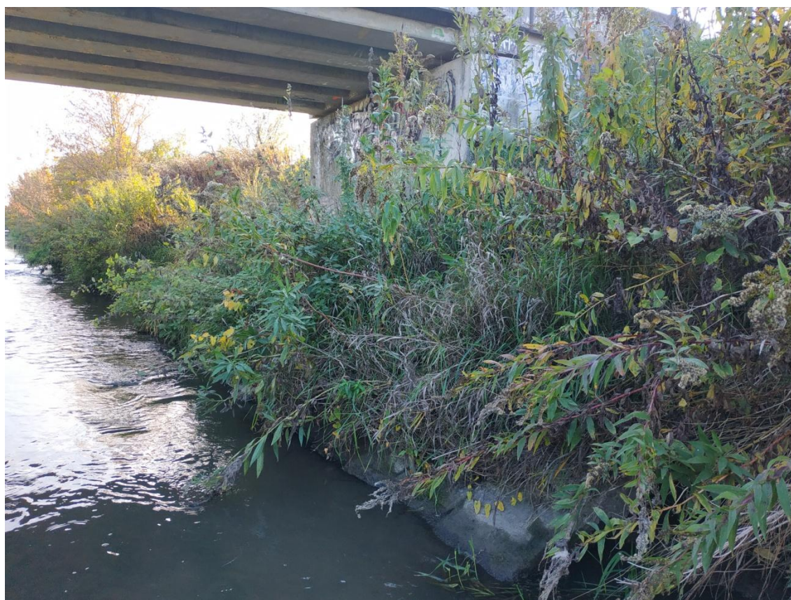
Obrázek 25. Detail opevnění mostu (16. 10. 2022)
