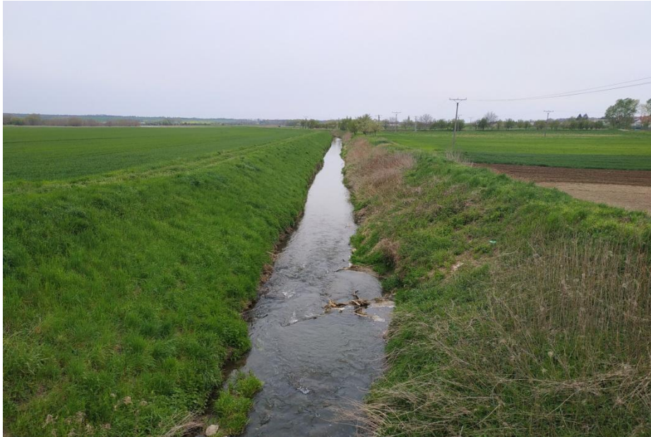
Obrázek 28. Koryto VT - pohled z mostu v části Obora (28. 04.2023)
