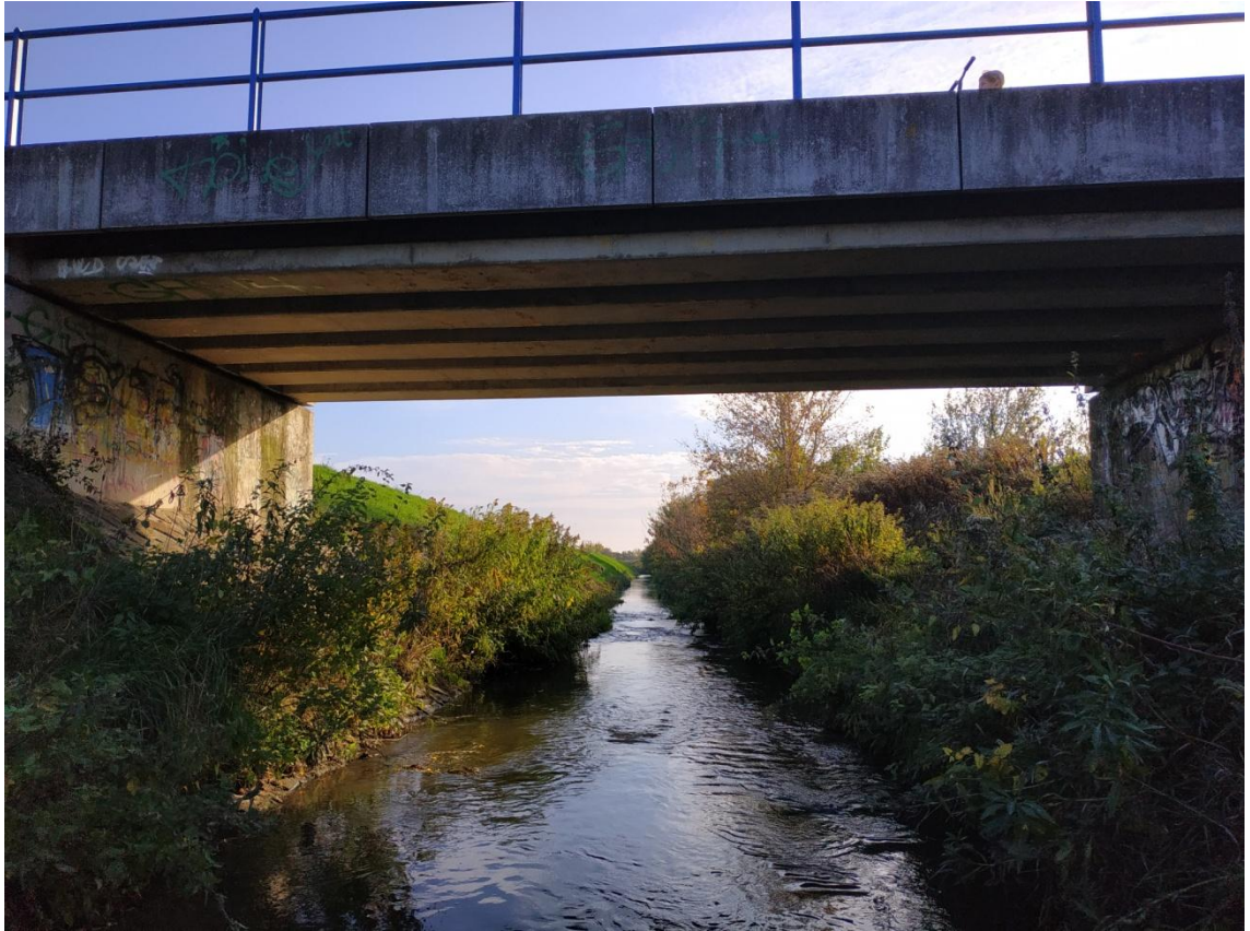
Obrázek 26. Pohled na most v části Obora (16. 10. 2022)
