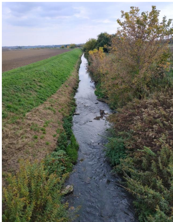
Obrázek 24. Pohled z mostu v části Obora na VT (11. 10. 2022)
